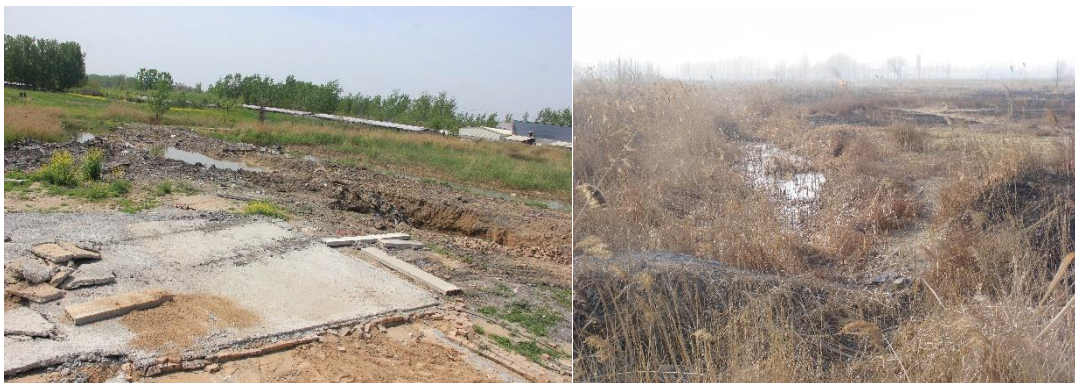
图 3.3-2 项目区现状照片
