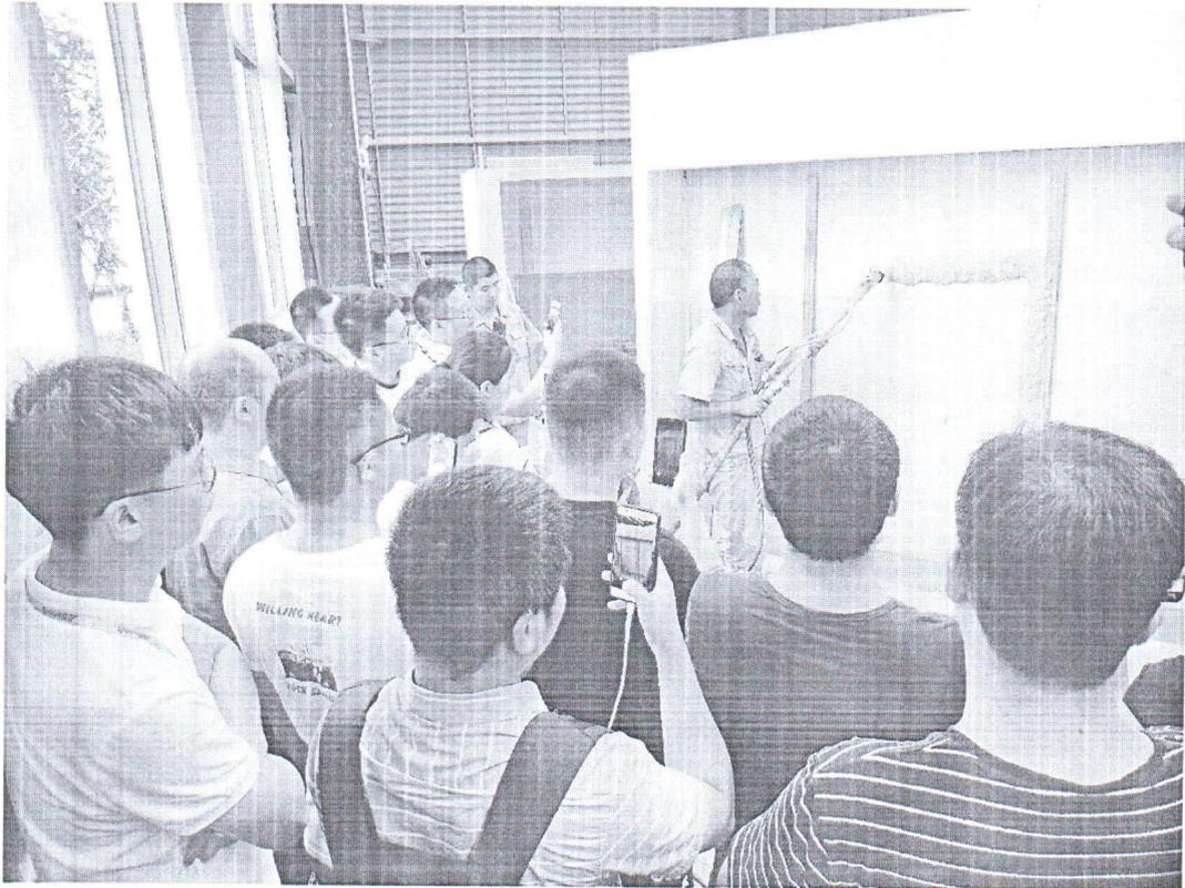
图 12 机械喷涂抹灰石膏施工演示
